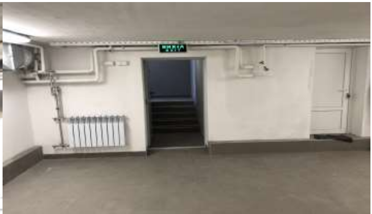
Після виконання робіт
