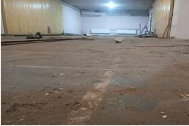
До початку проведення робіт
