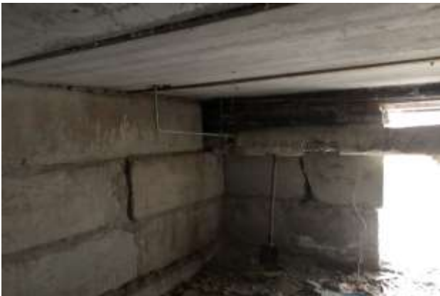
До початку проведення робіт
