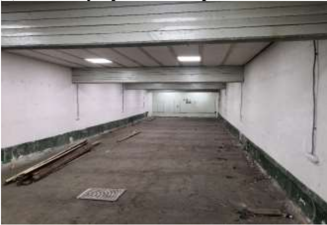
До початку проведення робіт
