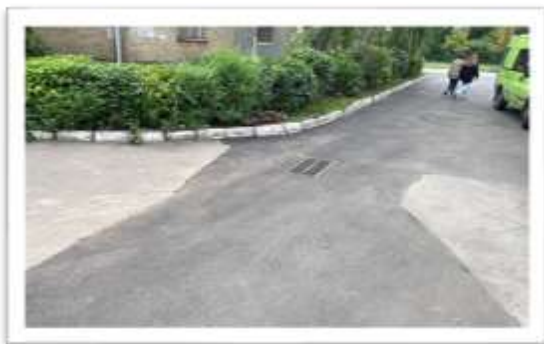
капітальний ремонт асфальтового покриття по вул. Будівельників, 29
