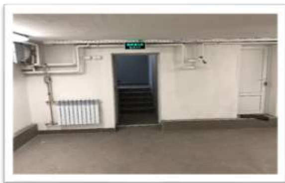
Ремонт найпростіших укриттів та захисних споруд цивільного захисту Комунального навчального закладу «Навчально-виховний комплекс «Берегиня» міста Києва (вул. Райдужна, 73)
