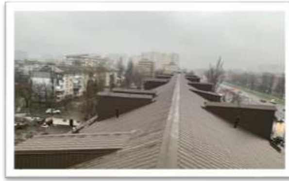
капітальний ремонт покрівлі житлового будинку на просп. Воскресенському, 20
