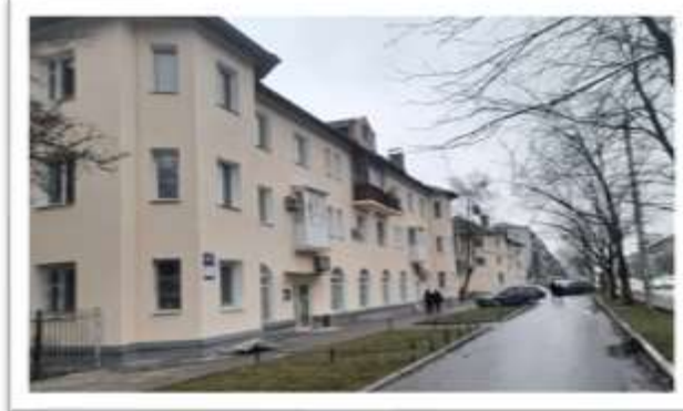
капітальний ремонт фасаду будинку на вул. Будівельників, 23
