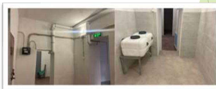
капітальний ремонт підвальних приміщень для використання під найпростіше укриття в ж/б на вул. Пластовій, 3-А
