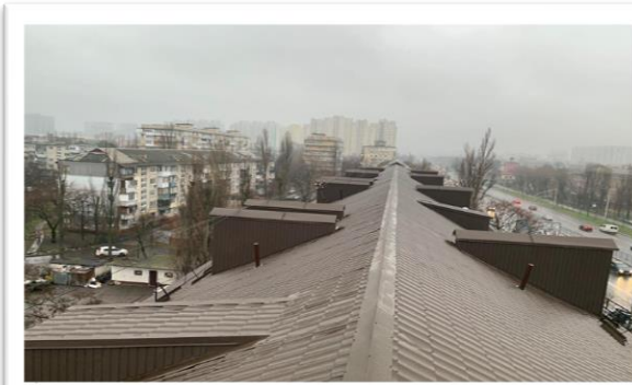
капітальний ремонт покрівлі житлового будинку на бульв. Перова, 20
