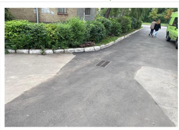
капітальний ремонт асфальтового покриття по вул. Будівельників, 29
