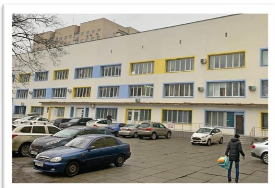
фасаду з утепленням із заміною вікон
