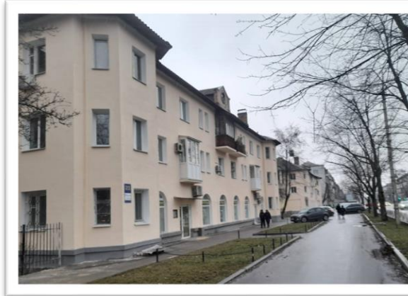
капітальний ремонт фасаду будинка на вул. Будівельників, 23
