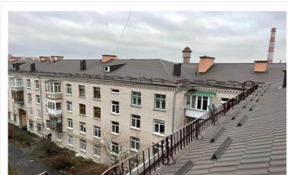
капітальний ремонт покрівлі житлового будинку на вул. Алматинська, 107/2
