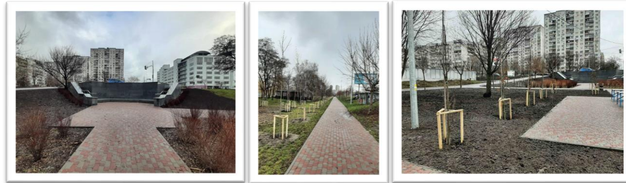
Капітальний ремонт парку «Радунка»
