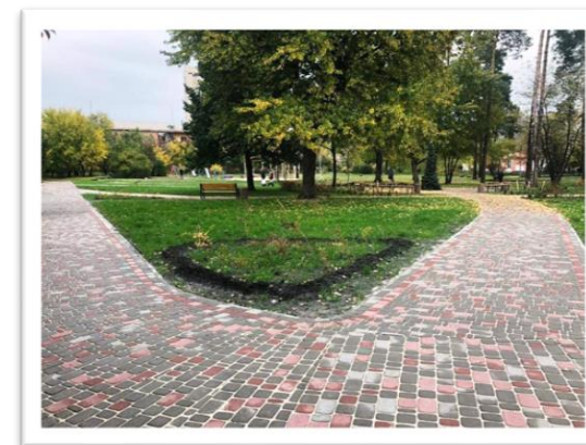
Капітальний ремонт скверу по вул. Інженера Бородіна
