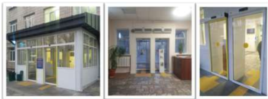
Капітальний ремонт входної групи КНП «Центр ПМСД «Русанівка» Дніпровського району м. Києва» (вул. Ентузіастів, 49)
