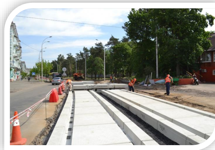
Капітальний ремонт вул. Алматинської (від вул. Празької до вул. Літинської) - площею 31 000 кв. м (розширили проїзну частину, замінено освітлення, прокладено систему зливоприймальної каналізації)
