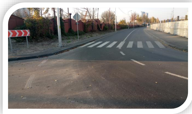
Капітальний ремонт вулиці Віфлеємської
