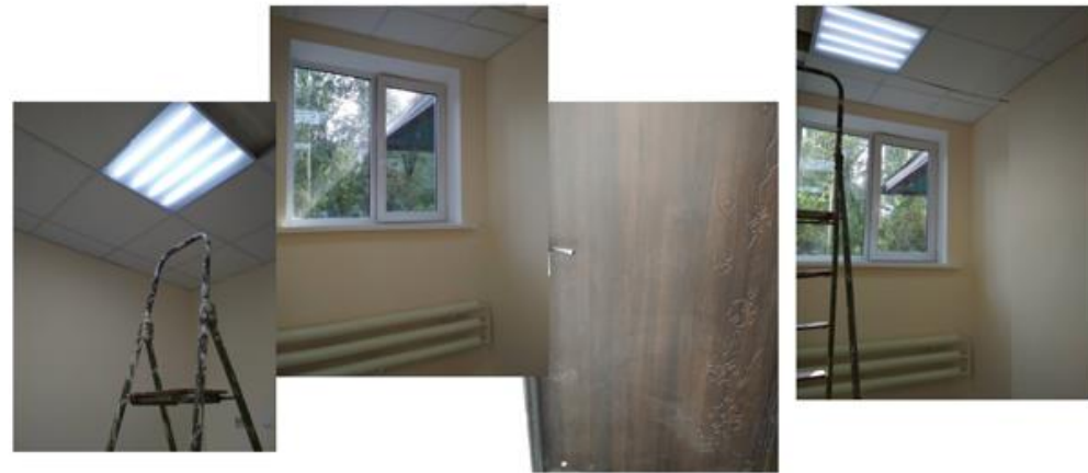
Ремонт дитячої музичної школи № 20 (вул. А. Бучми, 5)
