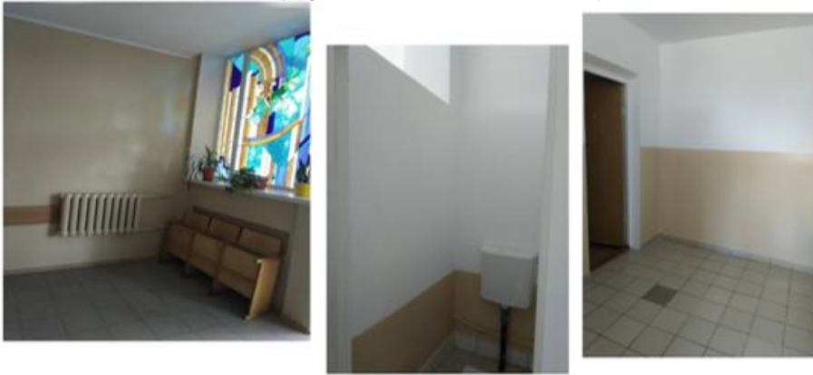
Ремонт дитячої музичної школи № 13 (вул. Е. Вільде, 5)
