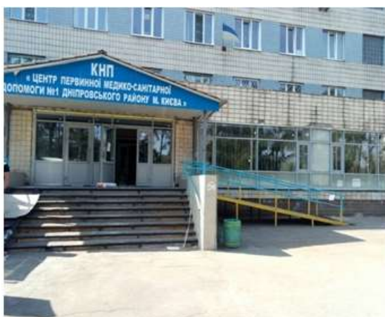
✓ Ремонт внутрішніх світлопрозорих конструкцій на вул. Петра Запорожця, 26
