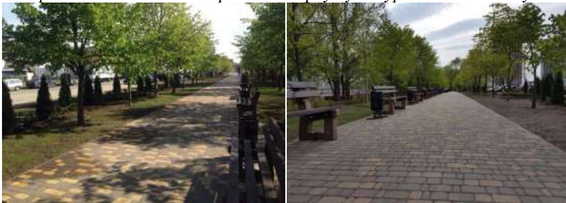
Капітальний ремонт скверу біля Міжнародного виставкового центру на проспекті Броварському
