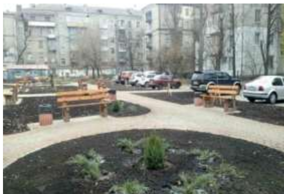
Капітальний ремонт скверу на вул. Будівельників, 36
