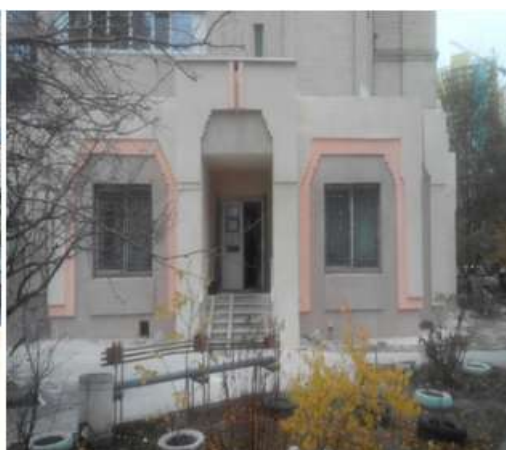
✓ Ремонт приміщень (фасад, вхідна група, вікна) на вул. Двінська, 19
